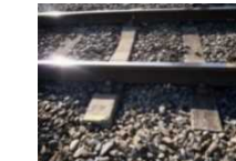
線路設備の修繕
