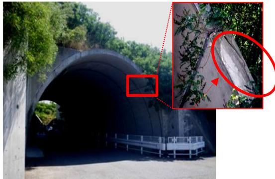
不同沈下による躯体の亀裂損傷状況
