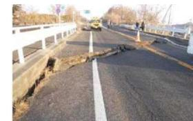
橋台背面の沈下により生じた段差により車両の通行が困難になった事例
