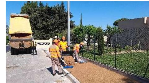
松脂を主原料とした代替材料の施工状況 (仏)
