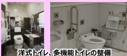
洋式トイレ、多機能トイレの整備
