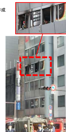
【火災建築物 外観】
