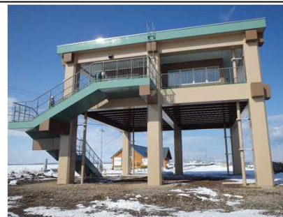
津波避難タワーの整備事例 (積雪寒冷を考慮した防寒機能付き)
