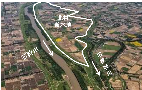
根幹的な治水対策として遊水地を整備
