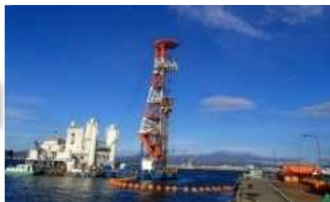
耐震強化岸壁の整備事例
