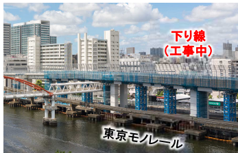
現在の工事状況(下り線の橋梁工事)
