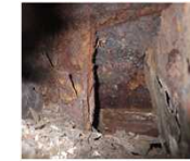
内面の腐食
