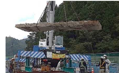
既設床版の撤去状況
