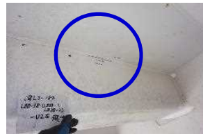
5号湾岸線 深江浜付近 (2020(R2)年5月撮影)
