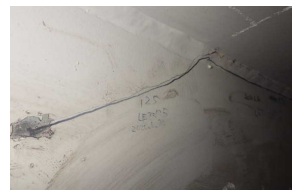
3号神戸線 西宮付近 (2020(R2)年6月撮影)
