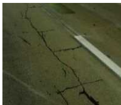
路面のひび割れ
