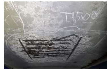
床版下面はく離、鉄筋の腐食
