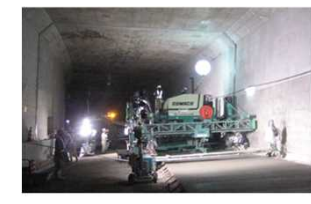
【例】連続鉄筋コンクリート舗装
