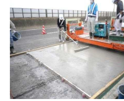
【例】鋼繊維補強コンクリート舗装
