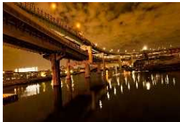
海上部の鋼床版 (湾岸線)
