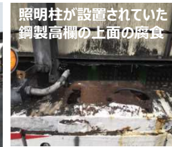
内面の腐食
