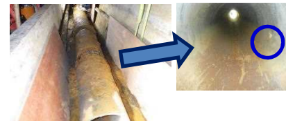
【例】劣化した消火本管の取替
