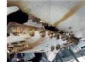
ガセットプレートの破断
