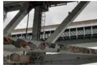
塗膜剥離による腐食
