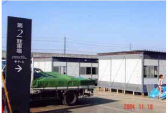
▲ 駐車場に建設された仮設住宅
