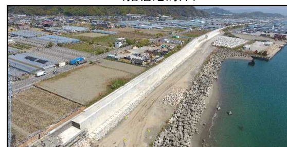
粘り強い構造の堤防整備 (高知港海岸)
