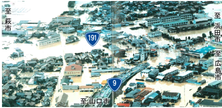
写真1 益田市内の浸水状況(昭和58年豪雨)
