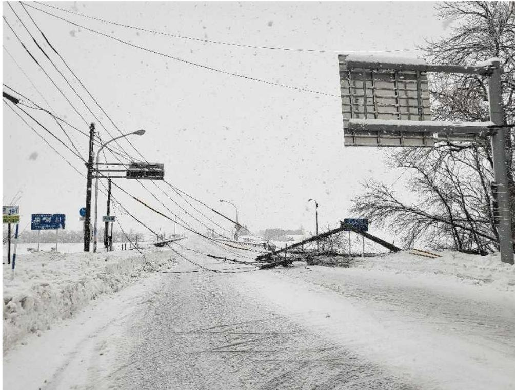
令和4年12月 暴風雪による電柱倒壊(R4.12.23)
