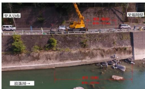
擁壁等における洗掘による変状事例
