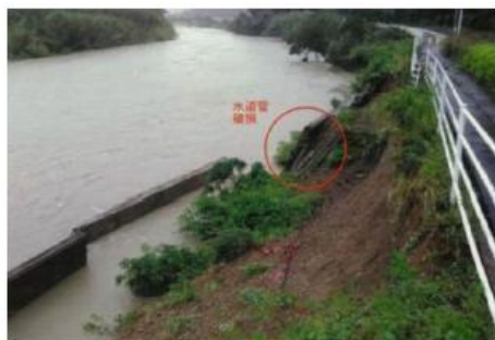
擁壁等における洗掘による変状事例
