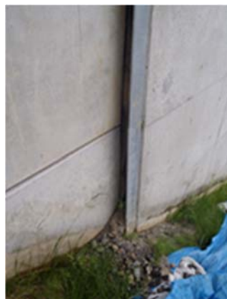
写真 土砂のこぼれ出し例
