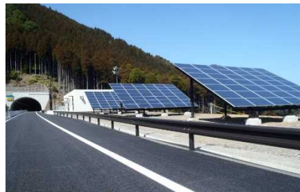
トンネル坑口付近における太陽光発電施設の設置事例
