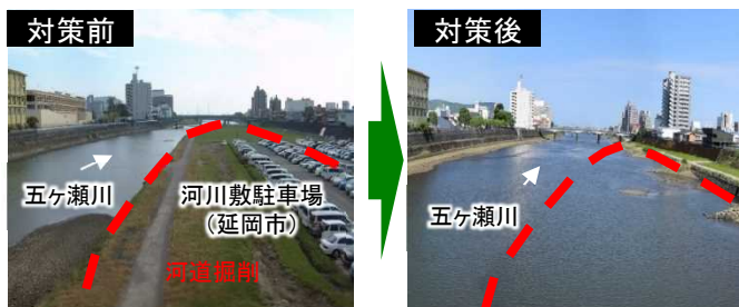
五ヶ瀬川の河川改修
