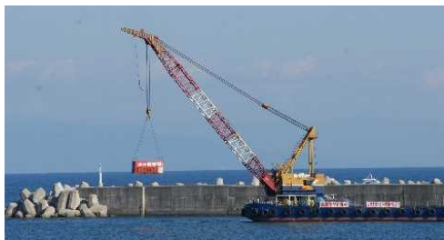
大規模津波防災総合訓練 (航路啓開訓練)
