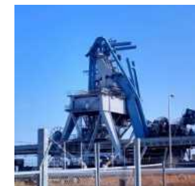
荷役機械の倒壊(相馬港)
