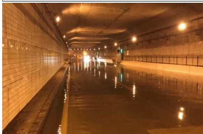
トンネルの冠水
