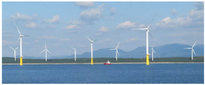
運転中の洋上風力発電事業(秋田港内)
