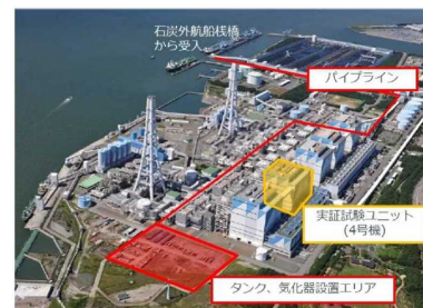
アンモニア混焼実証事業が行われる 愛知県碧南火力発電所
