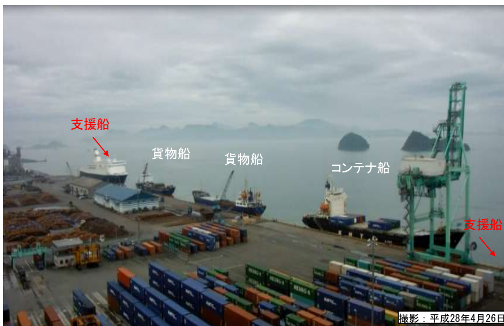
熊本地震発災後の八代港
