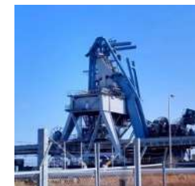
荷役機械の倒壊(相馬港)
