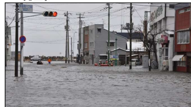
高潮による浸水 (北海道根室市)
