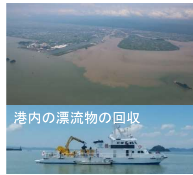
国による港湾施設の一部管理 (令和2年7月豪雨:八代港)
