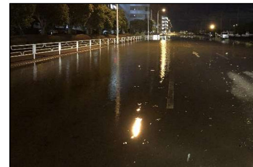
高潮による浸水 (神奈川県横浜市)
