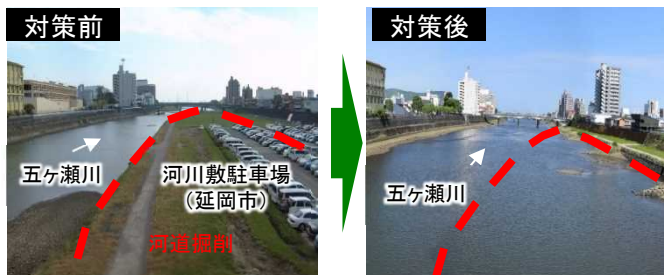
五ヶ瀬川の河川改修
