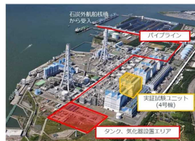
アンモニア混焼実証事業が行われる 愛知県碧南火力発電所
