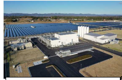
福島水素エネルギー研究フィールド
