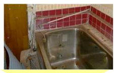
浴室改修前後
