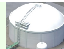
出典：川崎重工業(株)資料 水素受入基地の整備(大型液化水素貯蔵タンク)
