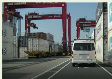
調査状況(RTG横走行)
