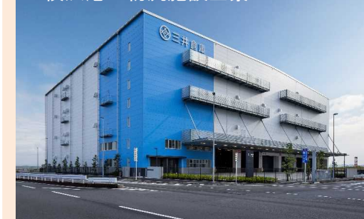
横浜港の物流施設全景
