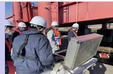
新技術を活用した施設点検の実施 (中国地方整備局)
