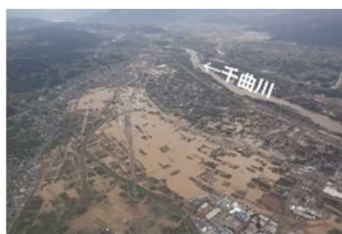
⑥千曲川における浸水被害 (長野県長野市)
