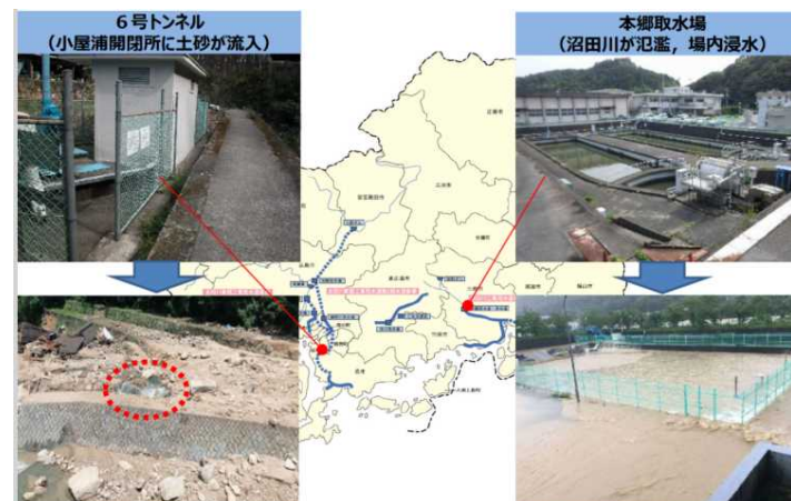
広島県工業用水の被災状況 1)
