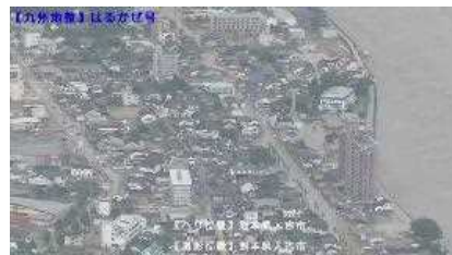
⑦球磨川における浸水被害 (熊本県人吉市)
