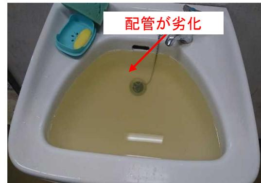
1階食堂手洗い:配管に劣化により、赤水が発生している
