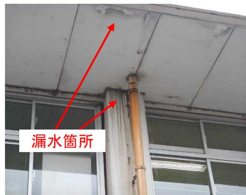
軒裏・柱面事務室側:軒裏、柱面からの漏水が見られる
