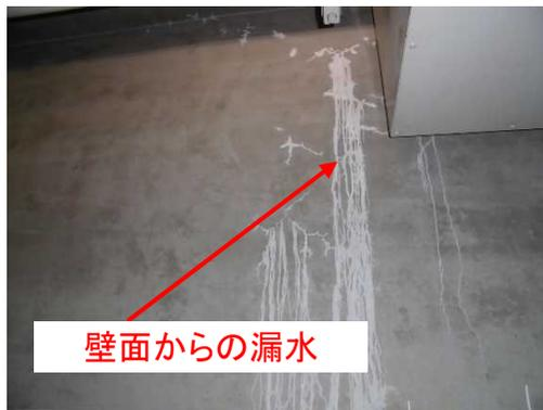
1階機械室外壁側:ひび割れからの漏水が見られる
