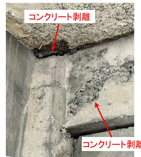
2階倉庫外壁側:柱のコンクリートの剥離・ひび割れが発生している
