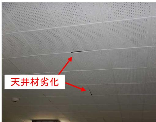
階段室天井:天井材の劣化が見られる
