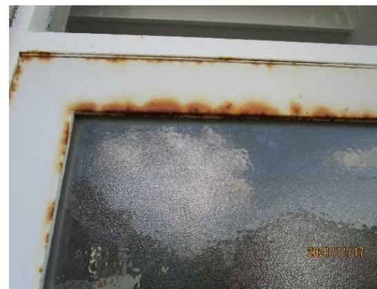
2階外部階段：外部鋼製建具に錆が発生している。
