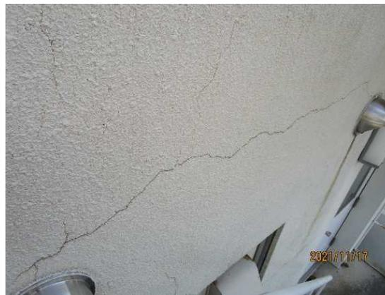
2階庁舎外壁：庁舎外壁にひび割れが多数発生している。
