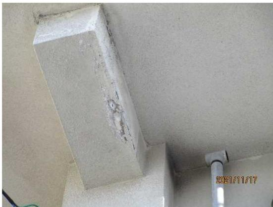
庁舎北側：外部持出し梁の躯体が欠損している。
