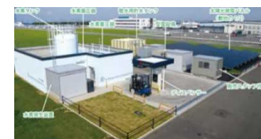
貨物地区水素充填所
