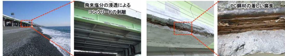
橋梁の損傷事例(左:コンクリートの剥落、右:鉄筋の著しい腐食)
