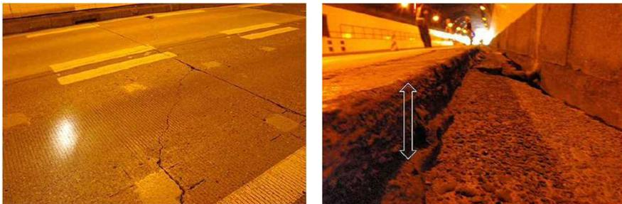
トンネルの損傷事例(左:路盤隆起によるひび割れ、右:路盤隆起による段差)
