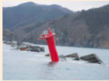
東北地方太平洋沖地震の被害
