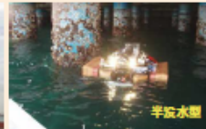
岸壁上部工下面の点検診断
