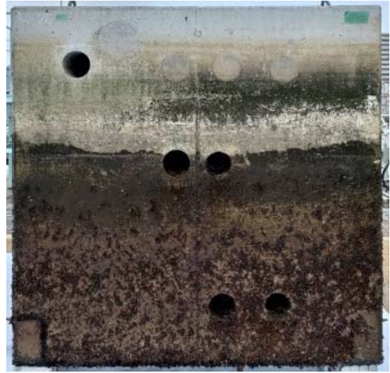
図 1.3.B33 暴露 1 年後の付着生物の状況
