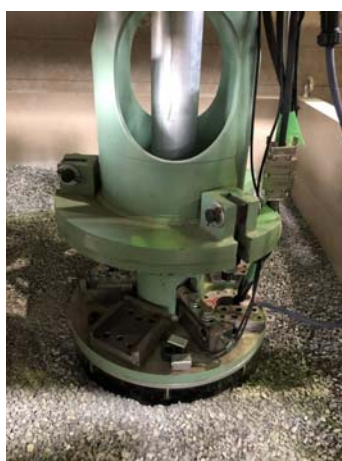
図 1.3.B89 掘削マシンの貫入
