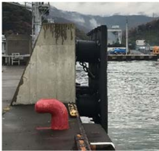
図 1.3.C11 受衝板付き防舷材の例
