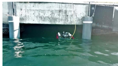
図 1.3.B42 模擬杭を用いて測位を行いながら 栈橋下面の撮影を行う点検用 ROV(舞鶴港)
