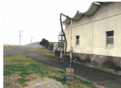
下水処理水給水所
