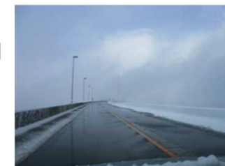
散水消雪区間
