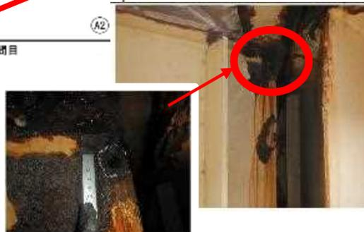
2021年点検 主桁端部の腐食の進展 (III)
