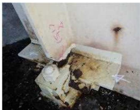
2016年点検 垂直補剛材の腐食 (III)
