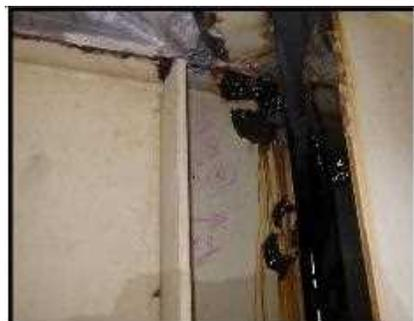
2016年点検 主桁端部の腐食 (II)
