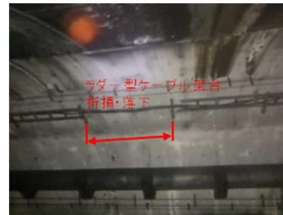
振れ止め金具の固定ネジが腐食により外れている。
