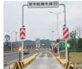
料金所手前の重量計測レーン
