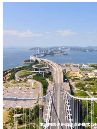
瀬戸大橋（瀬戸中央自動車道）
