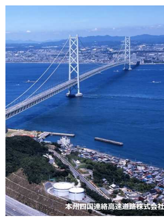
明石海峡大橋（神戸淡路鳴門自動車道）
