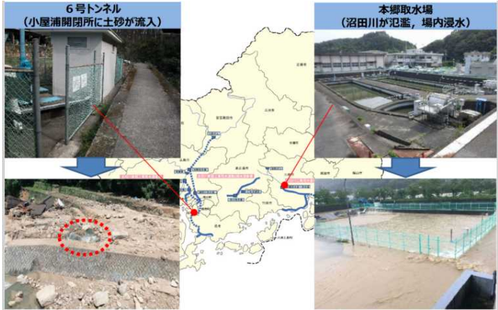
広島県工業用水の被災状況 1)
