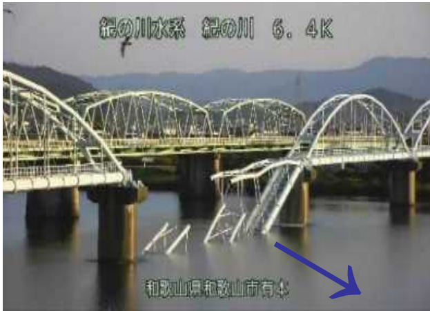
六十谷水管橋落橋状況 (和歌山県国道事務所CCTV)
