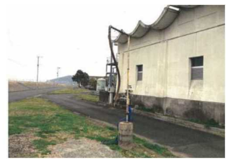
下水処理水給水所
