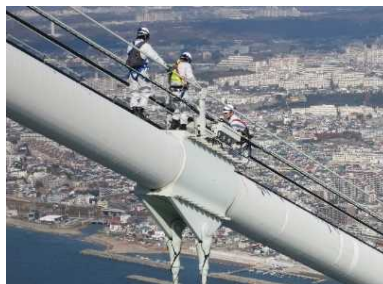
ケーブルの点検
