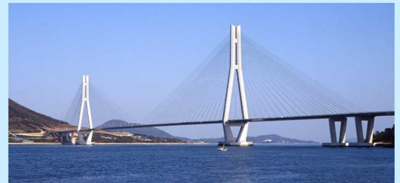
日本最長の斜張橋・多々羅大橋
