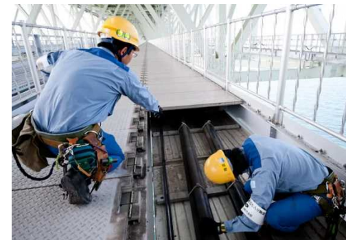
出典: 関西電力送配電HP (明石海峡大橋に添架されている電力ケーブル)
