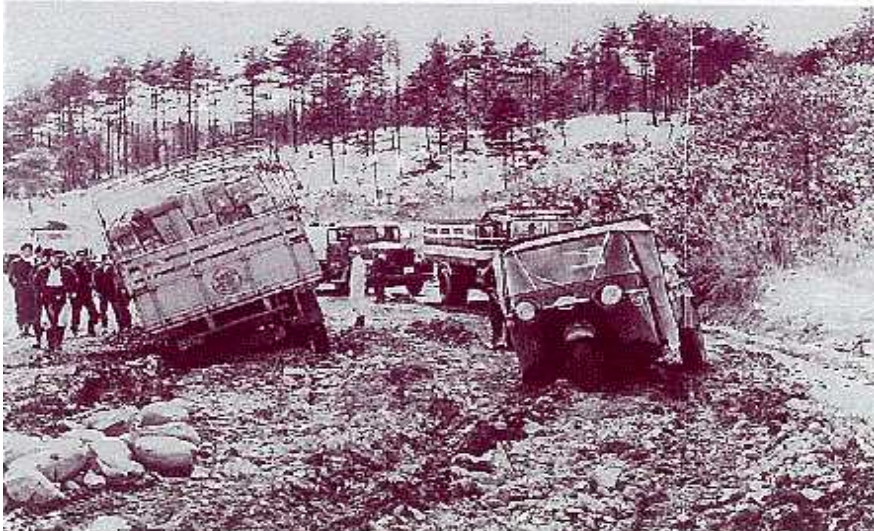
1級国道20号、塩尻峠付近（1957年当時）
