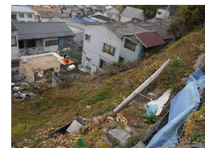
高台から瓦礫や岩石、柵等が落下するおそれ
