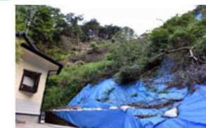
豪雨の度に土砂崩れが多発
