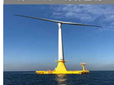
洋上風車の浮体基礎
