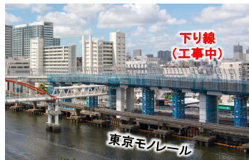
現在の工事状況(下り線の橋梁工事)
