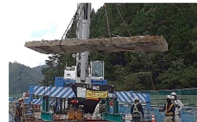
既設床版の撤去状況
