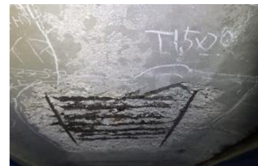
床版下面はく離、鉄筋の腐食
