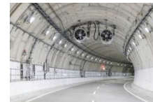
【トンネル内照明・換気設備の更新】
