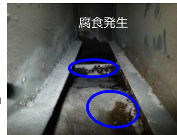
防食材の適用箇所(鋼製高欄の内部)における再腐食 (13号東大阪線 森之宮付近)
