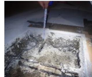
舗装面のはつり調査 (PC鋼材の目視確認)
