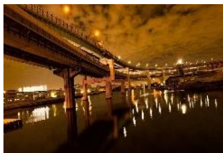
海上部の鋼床版 (湾岸線)
