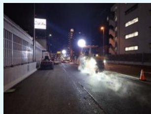
交通影響が小さくなる夜間の車線規制工事 (騒音が少ない工種・工法に限定)
