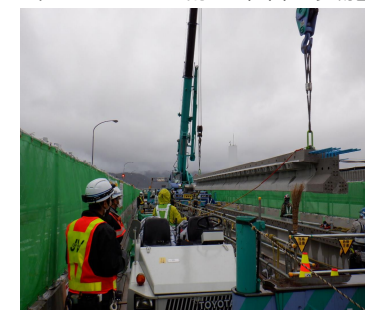
対策イメージ(桁の架替)
