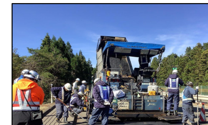
高耐久路盤舗設 ➢アスファルトフィニッシャーにより敷き均し
