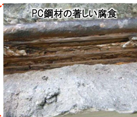
PC鋼材の変状状況
