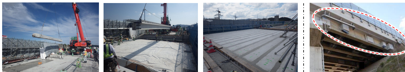
桁の切断・撤去
