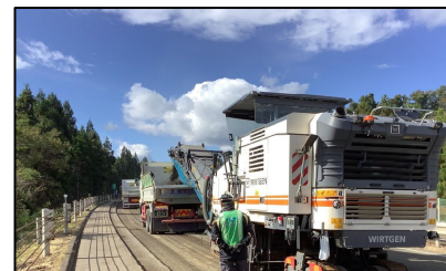
舗装開削・既設路盤撤去 ➢路面切削機により既設舗装を撤去
