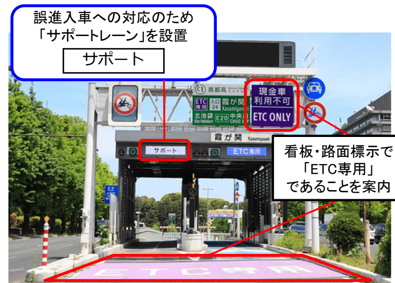
ETC専用化した首都高速道路都心環状線霞が関(外回り)入口
