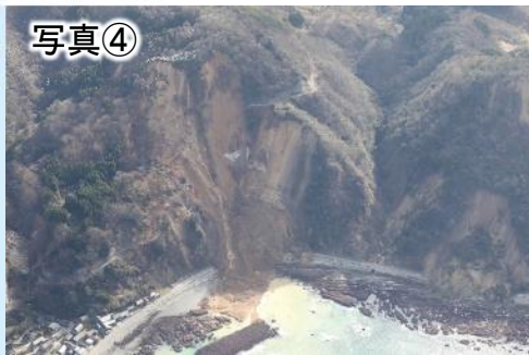
国道249号法面崩落
