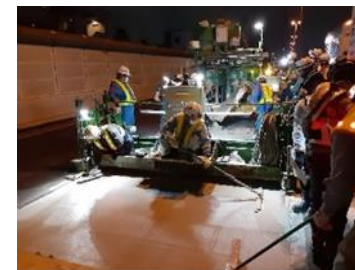
施工状況（7号小松川線）
