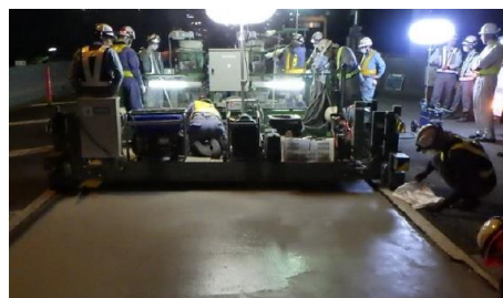
施工状況（1号上野線）
