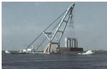
巨大な鋼鉄製の橋脚
