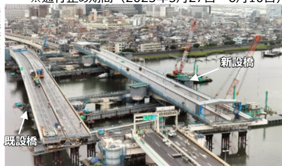
既設橋のスライド撤去状況
