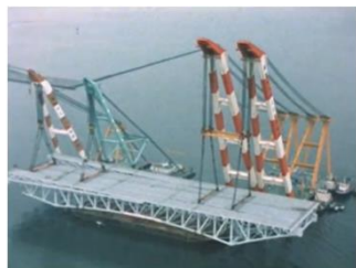
一径間分を一挙に架設
