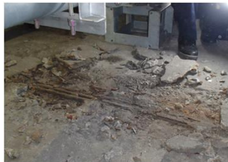
中床版上面の鉄筋一部消失
