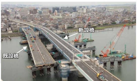
新設橋のスライド架設状況
