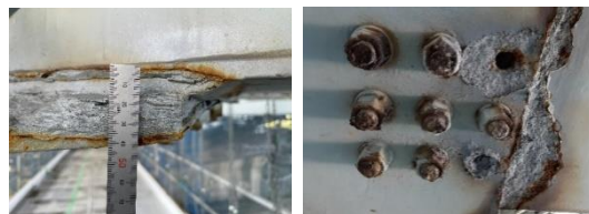
部材接合部腐食 (膨張・変形) ボルト腐食・破断
