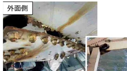
ガセットプレートの腐食・破断 ※破断箇所は応急補修済
