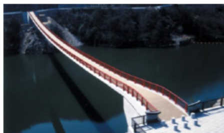
直路式吊床版橋
