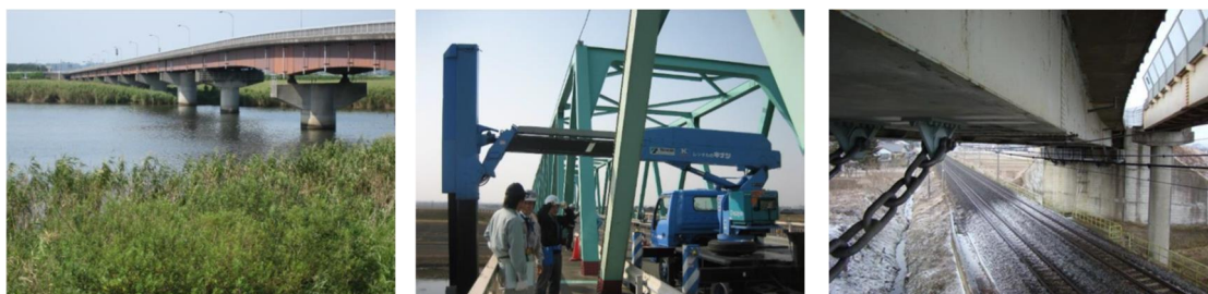
図-参 2 通行の規制時間や点検の時間の縮減が期待される橋の例
