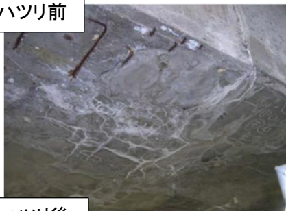
※写真はPC桁下面のひびわれ事例
