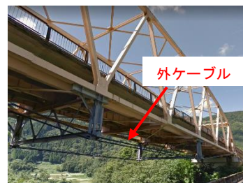
鋼橋の外ケーブル補強の例
