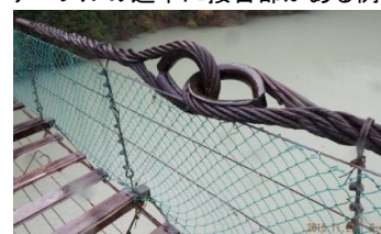
ケーブルの途中に接合部がある例
