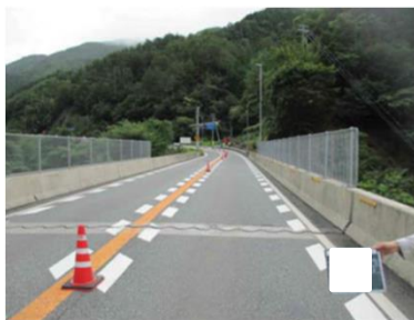
浮き上がりが無いか確認する
