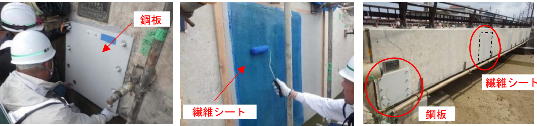
写真 2.3 横締め PC 鋼材の突出防止対策
