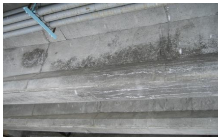
※写真はPC桁下面のひびわれ事例
