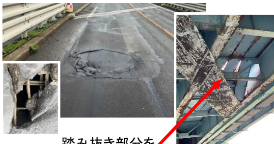
踏み抜き部分を はつり落とした後の床版下面の状況
