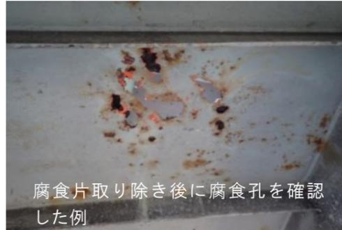
腐食片取り除き後に腐食孔を確認した例
