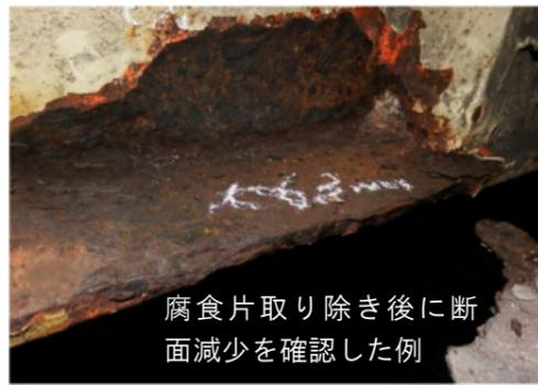
腐食片取り除き後に断面減少を確認した例
