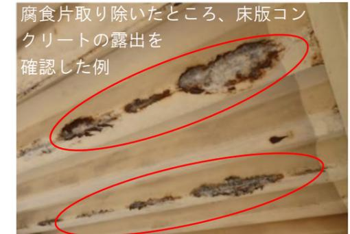
腐食片取り除いたところ、床版コンクリートの露出を確認した例
