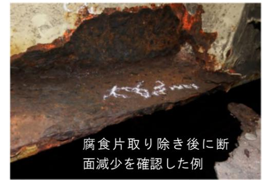
腐食片取り除き後に断面減少を確認した例
