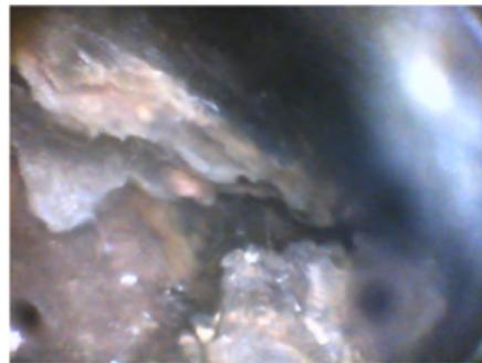
地覆内部で滞水を確認：主桁側面腐食状況
