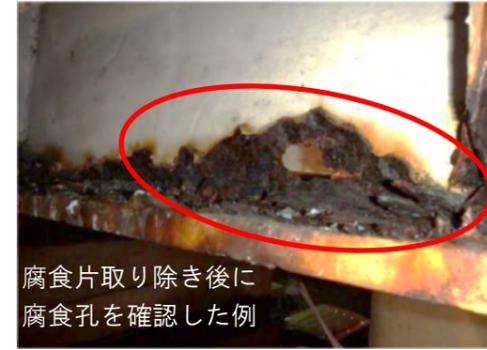
腐食片取り除き後に腐食孔を確認した例
