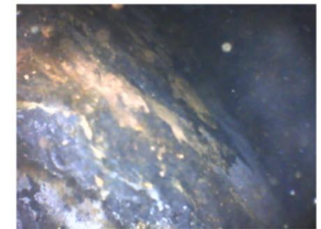
地覆内部で滞水を確認：波板側面腐食状況
