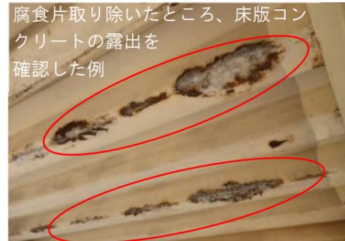
腐食片取り除いたところ、床版コンクリートの露出を確認した例
