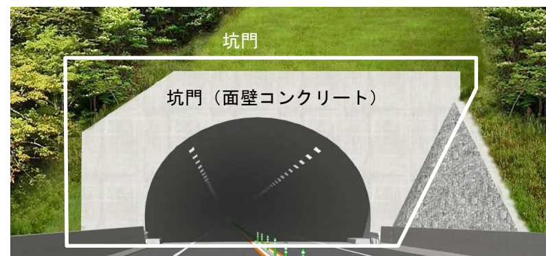
別図-1.2 定期点検対象箇所の例（トンネル坑口部）
