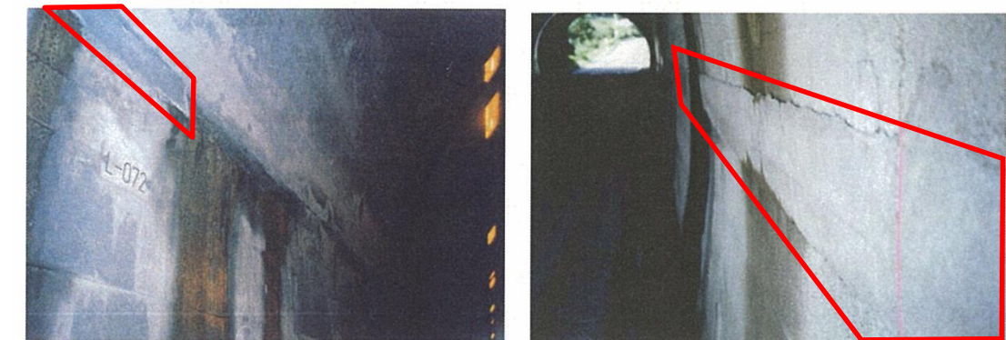
目地モルタルの例
