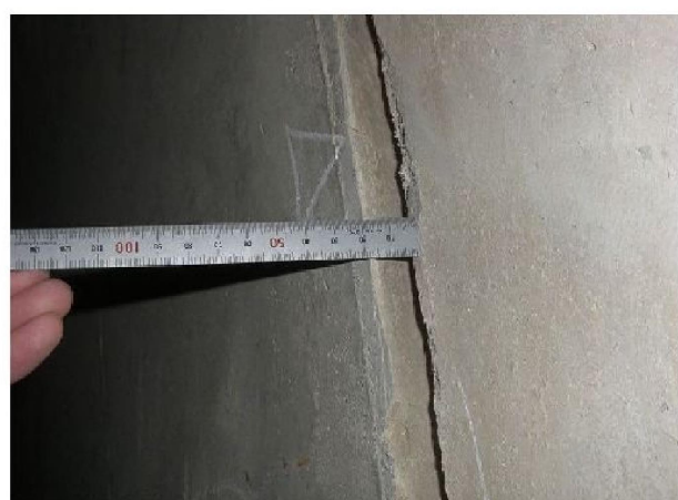
付図-2.4.5 目地部、打継ぎ目部の段差の例
