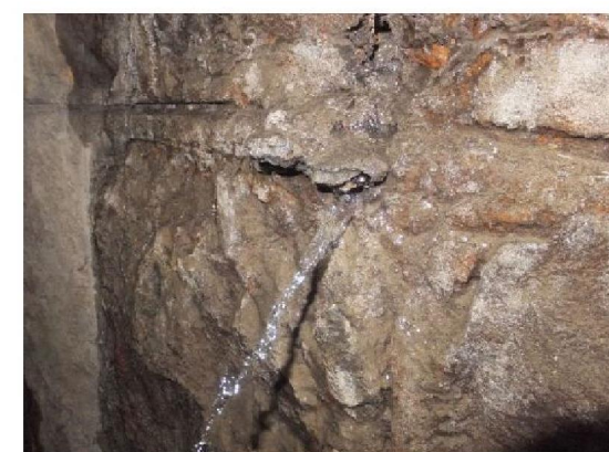
付写真-2.4.3 漏水（噴出）している例
