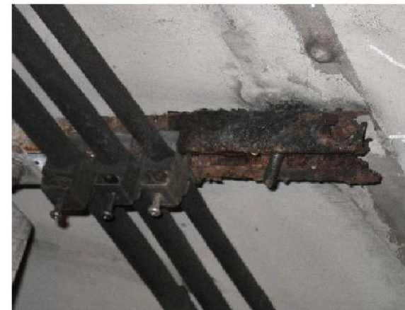
付写真-2.5.1 固定金具の腐食とアンカーボルトの脱落の例
