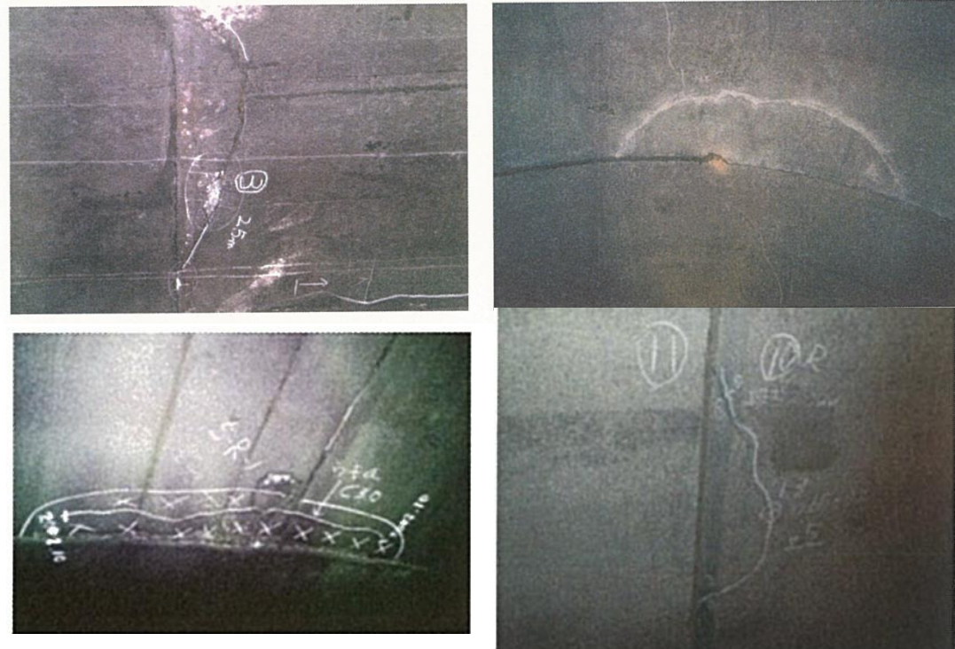
付写真-2.1.1 横断目地の天端付近に発生した半月状のひび割れの例
