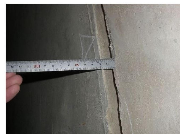
付図-2.4.5 目地部、打継ぎ目部の段差の例
