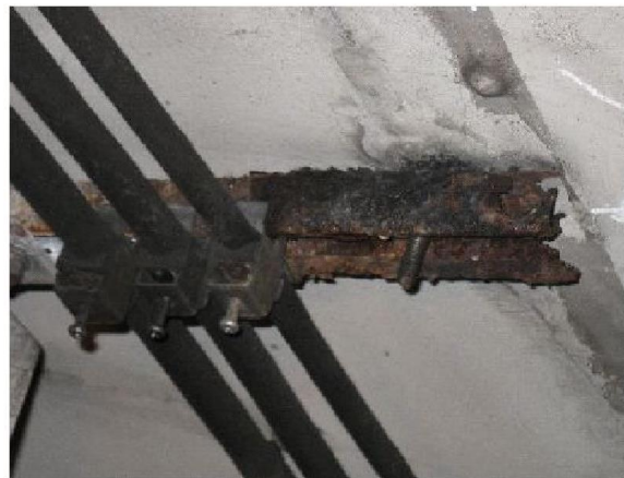
付写真-2.5.1 固定金具の腐食とアンカーボルトの脱落の例
