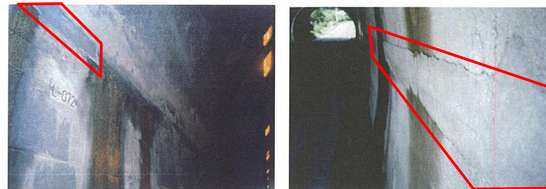
目地モルタルの例
