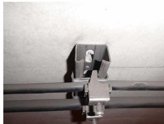
付写真-2.5.1 固定金具の腐食とアンカーボルトの脱落の例
