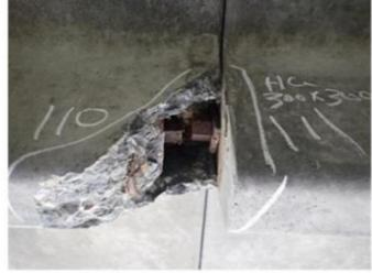
PC横梁の定着部に欠損がみられ安全性の低下が生じる可能性がある。
