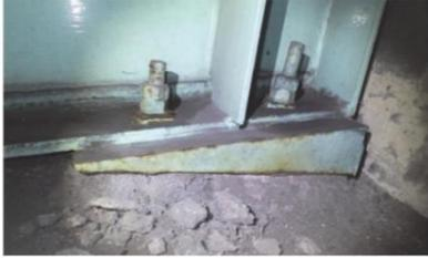
支承部モルタルが破損し、腐食したアンカーボルトが緩むなど、支承の機能に影響を及ぼしている。
