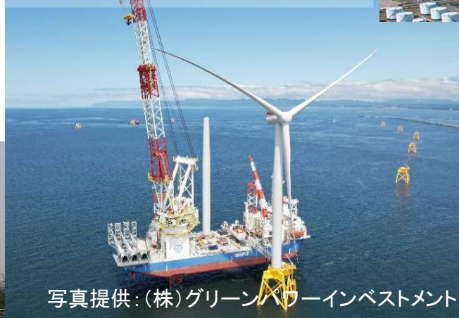
風車建設時の様子(令和5年7月)
