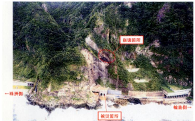
写真-7.3.25 被災箇所の被災前全景(復旧後調査資料より)
