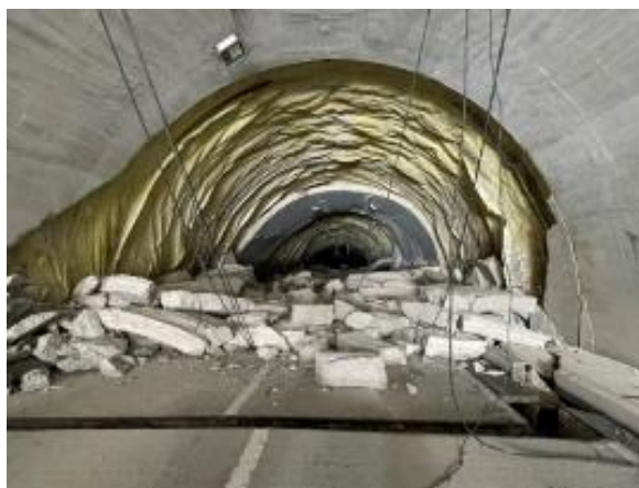
大谷トンネル(国道249号)
