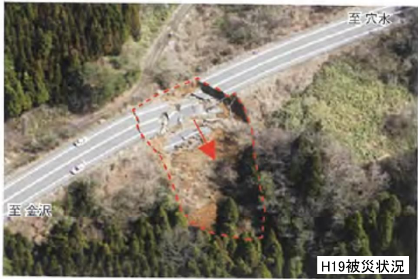
上下線の崩落 (H19.3月)
